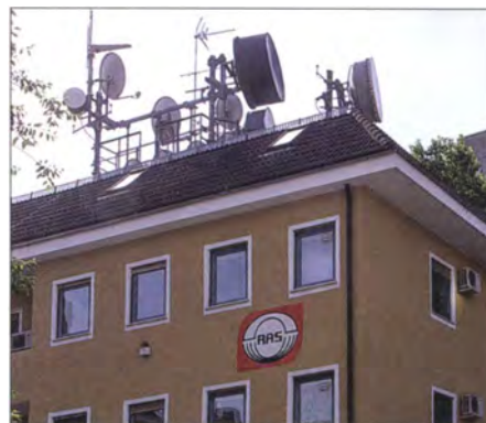
Bild 7: Zentrale der RAS in Bozen mit den Richtfunkantennen auf die Sendestandorte
