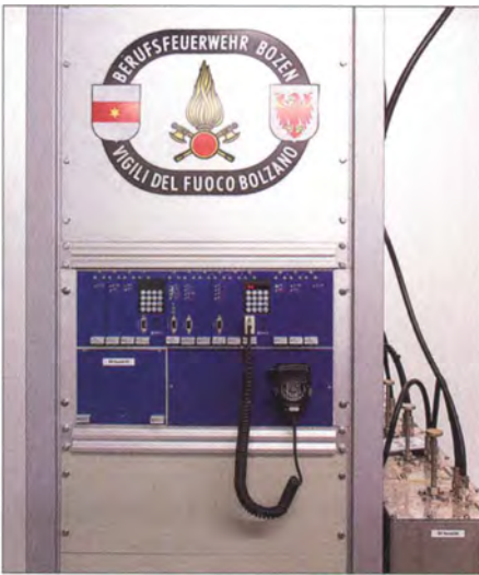
Bild 9: Umsetzer der Berufsfeuerwehr Bozen mit Filtern (rechts)
