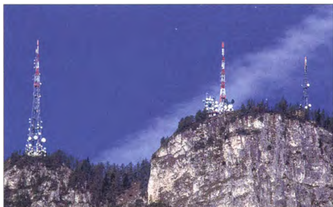
Bild 5: Sendeanlage Penegal, von Eppan aus gesehen
