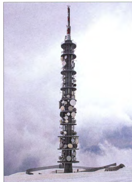
Bild 3: Oberirdischer Teil der RAS-Sendeanlage Kronplatz
